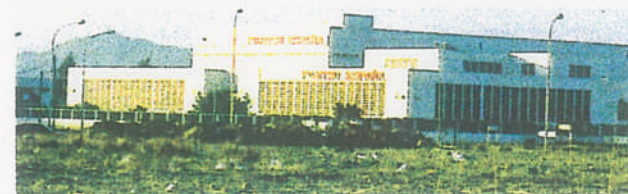
La factoría Fujitsu, fue en Málaga la primera experiencia en la incorporación de nuevas tecnologías y servicios avanzados dentro del propio recinto de fabricación.
