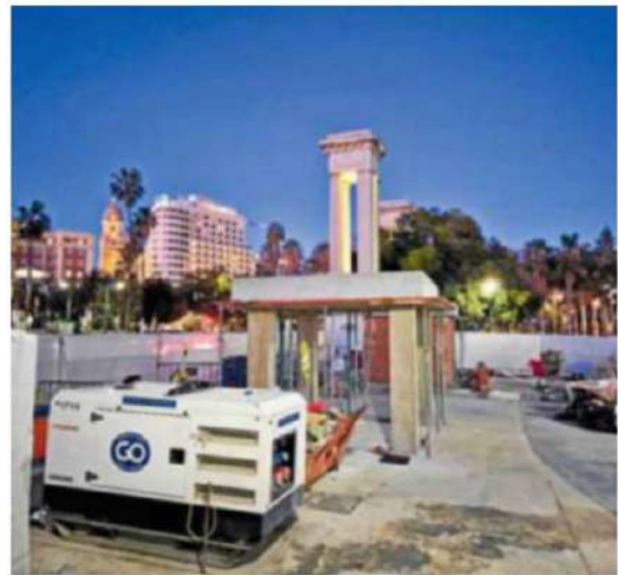
Estado de las obras en la actualidad. PEDRO J. QUERO
