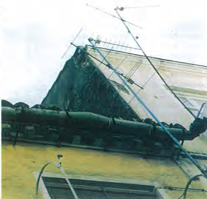
C. Hiestrosa, 12. LOS CANALONES CERÁMICOS POLICROMADOS SUELEN REQUERIR LA SUSTITUCIÓN TOTAL
