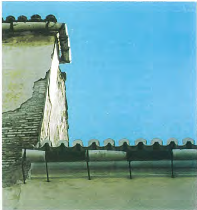
C. Carretería, 62 LOS CANALONES DE CERÁMICA VIDRIADA MULTICOLOR SON CARACTERÍSTICOS DE LOS EDIFICIOS DEL BARROCO MALAGUEÑO
