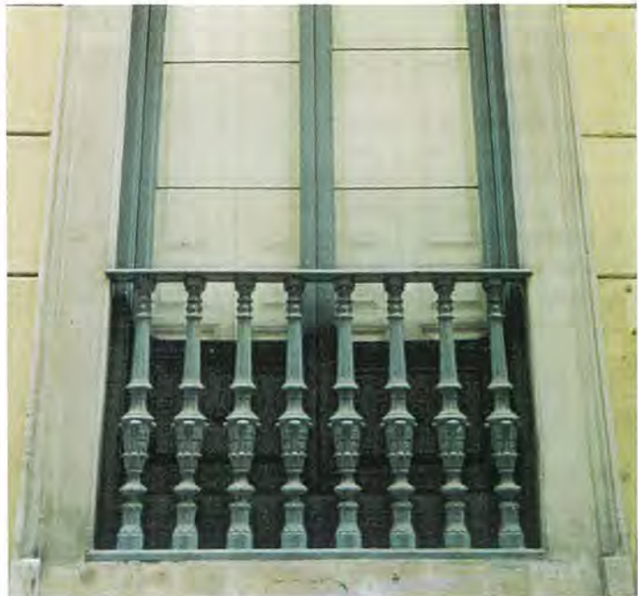
C. Marqués de Guadiaro, 4. LA FUNDICIÓN EN LA CERRAJERÍA ES UNA TÉCNICA INTRODUCIDA POR EL ECLECTICISMO
