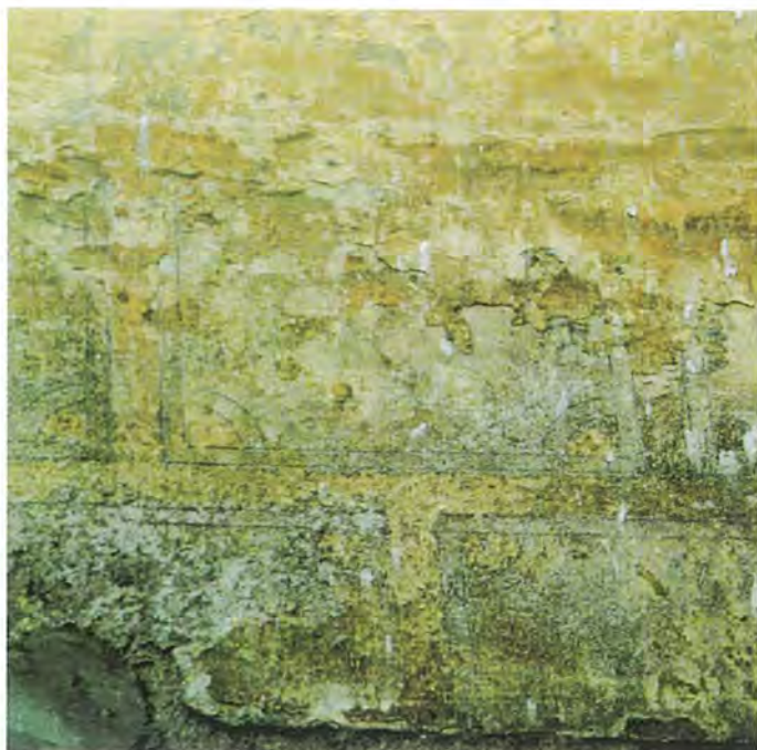
C. Don Juan de Málaga, 7 REVESTIMIENTO IMITACIÓN SILLERÍA
