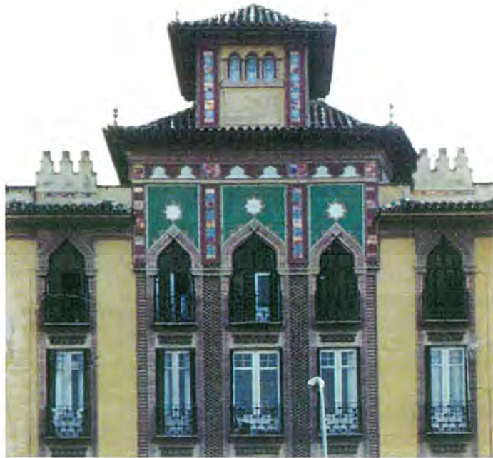
Av. Rosaleda, 3 LOS REMATES ORNAMENTALES TRATAN DE DESTACAR LOS EDIFICIOS DE SU ENTORNO INMEDIATO
