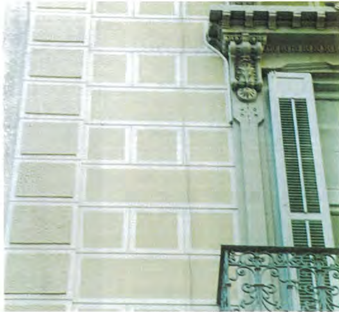
C. Liborio García, 10 PARAMENTO CON DESPIECE EN REVOCO MARCANDO AVIVADOR A ROMPEJUNTAS
