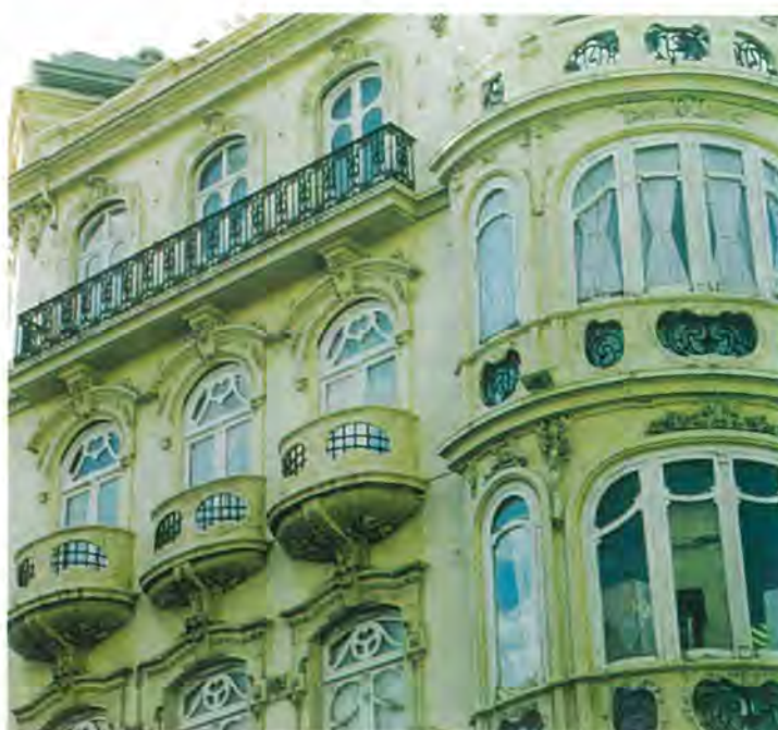
Pl. Félix Sáenz, 4 FACHADA RESUELTA COMPLETAMENTE CON MOLDEADOS DE PIEDRA ARTIFICIAL
