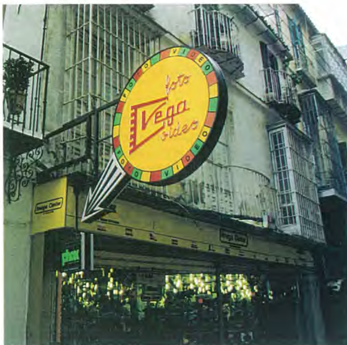
C. Granada, 50 LOS RÓTULOS NO DEBEN ROMPER LA COMPOSICIÓN ARQUITECTÓNICA GENERAL
