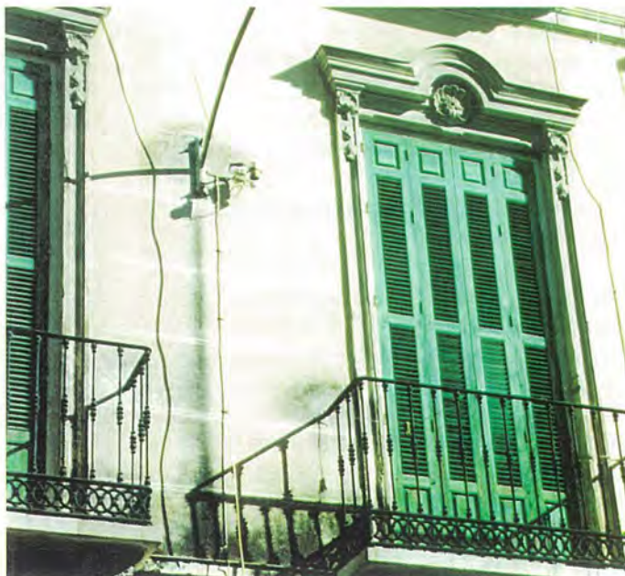
C. Madre de Dios, 44 PARAMENTO EN REVOCO MARCANDO JUNTA CORRIDA EN EL PISO Y AVIVADOR EN LOS BAJOS
