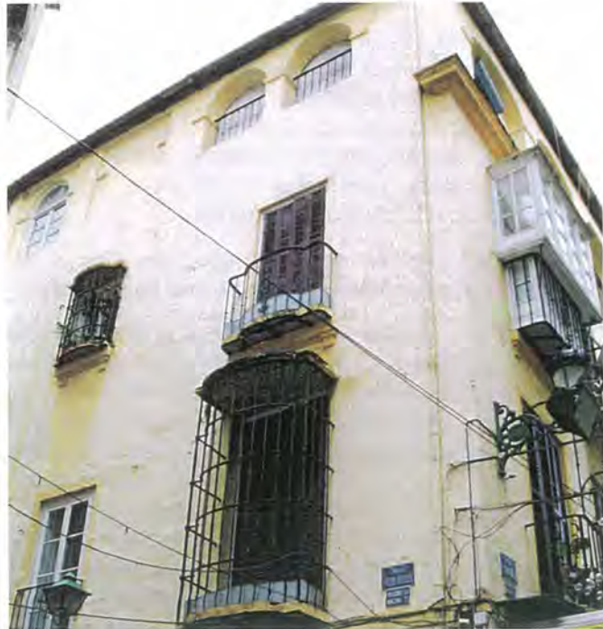
C. Compañía, 26 / C. Pozos Dulces. EN LA FACHADA BARROCA CONVIVEN HUECOS DE DIFERENTES MEDIDAS Y PROPORCIONES
