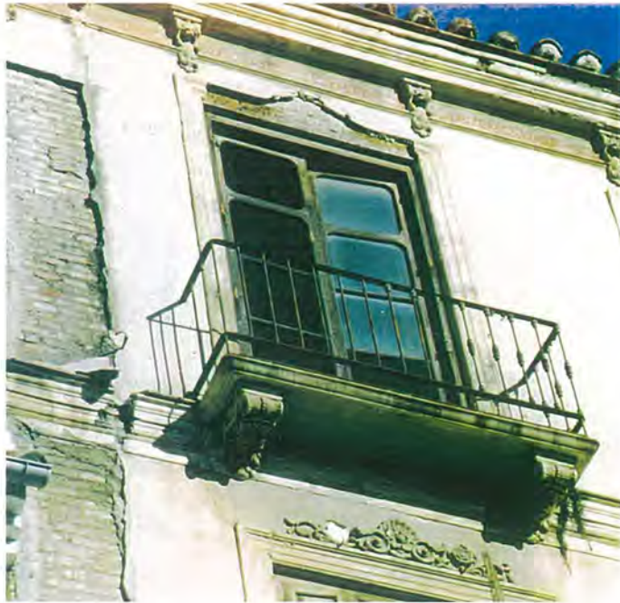
C. Biedmas, 16. ES IMPORTANTE REPRODUCIR FIELMENTE LA MOLDURACIÓN DE LOS RECERCADOS
