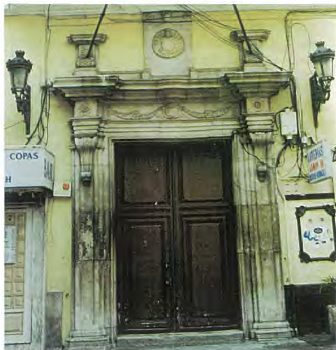
C. Granada, 61. Palacio de los Gálvez. LA PUERTA DE ACCESO SUELE SER EL ÚNICO ELEMENTO MOLDURADO DE LA FACHADA
