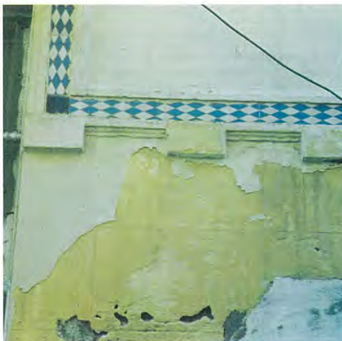
C. Hínestrosa, 19 LOS PARAMENTOS DEBEN MANTENER COLORES Y TEXTURAS ORIGINALES
