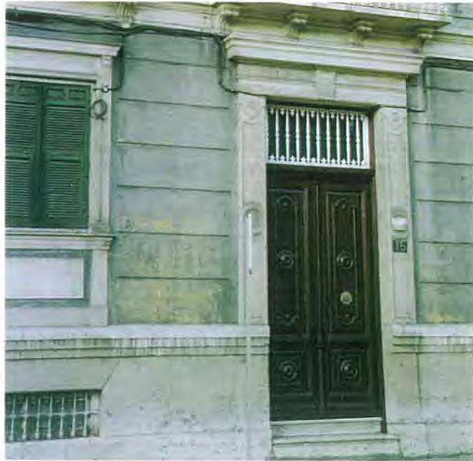
Cortina del Muelle, 15. TRATAMIENTO PÉTREO MAZIZO DE UNA PLANTA BAJA EN CORRESPONDENCIA A LA CONCEPCIÓN NEOCLÁSICA GENERAL DE LA FACHADA
