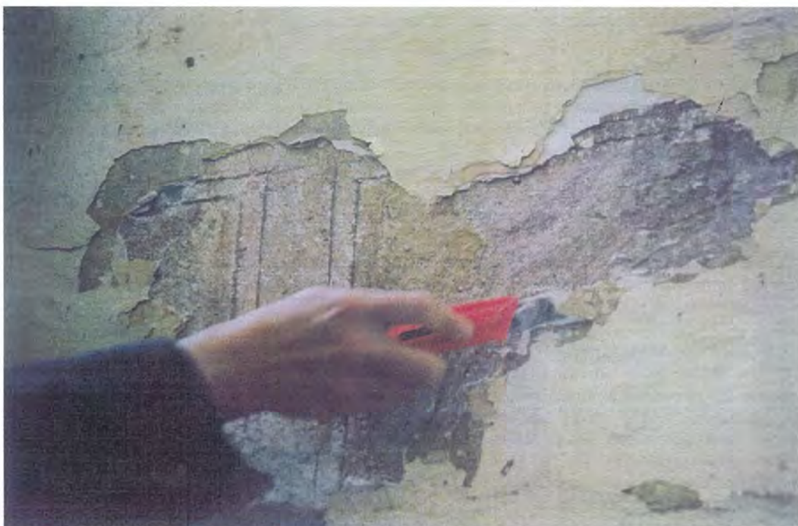
C. Tomás de Cózar, 29. Decapado de un encalado para descubrir el almohadillado barroco.
